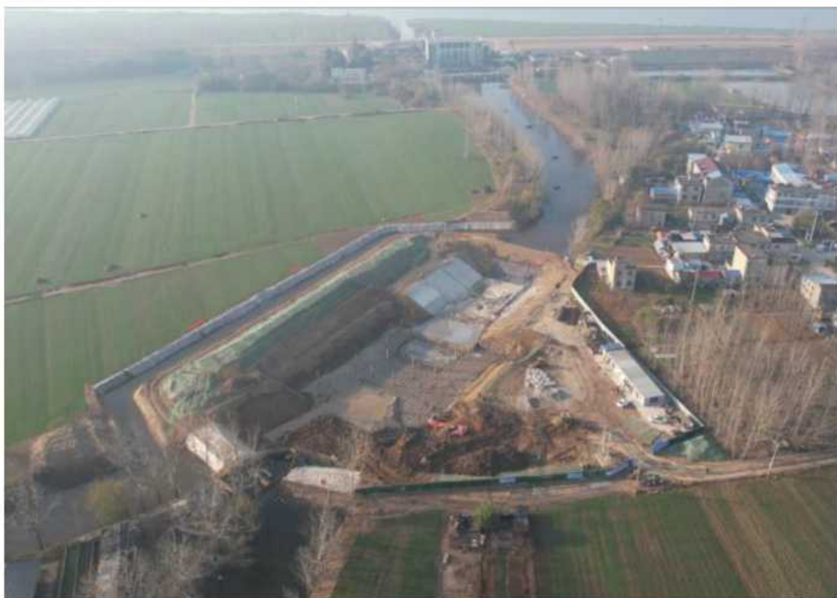
图 1-8-2 三铺大沟在建节制闸
