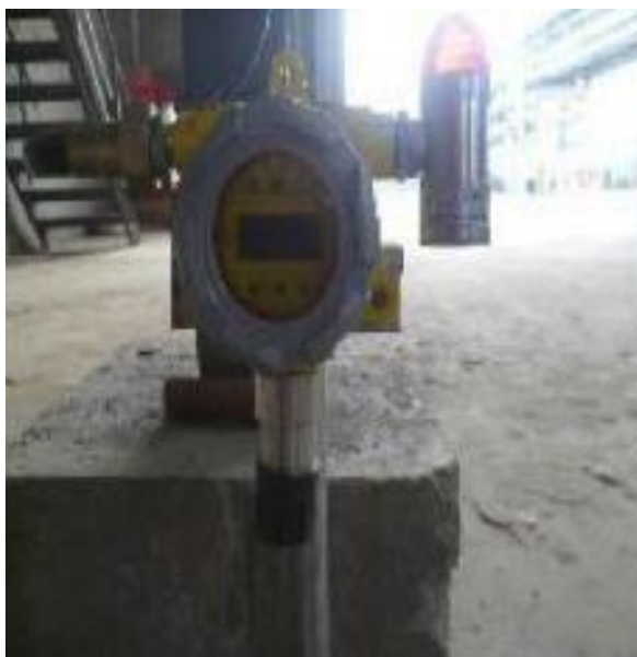
液氯储罐有毒气体探测器
