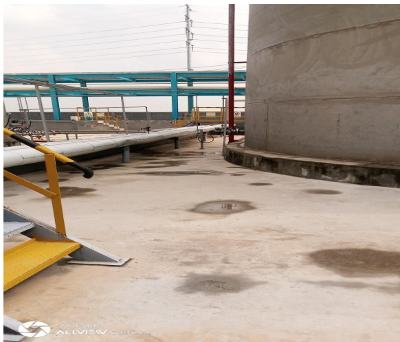
储罐罐区围堰
