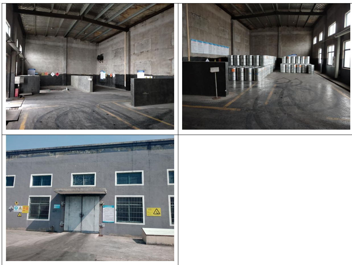
图 7.4-1 厂区危废贮存库现状图
