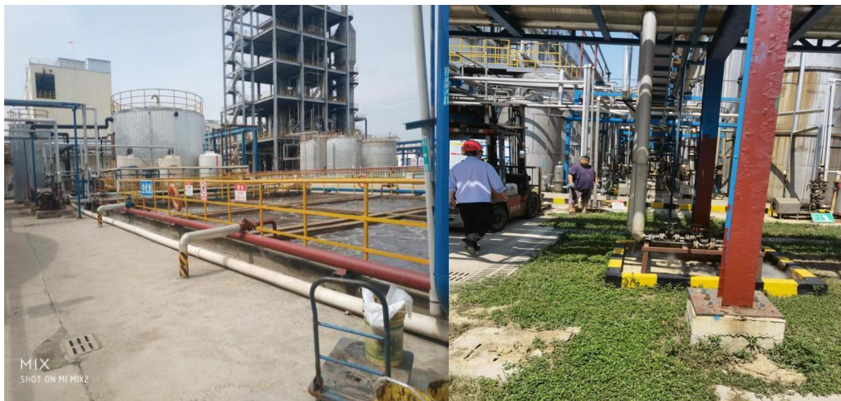
厂区污水处理站现状
