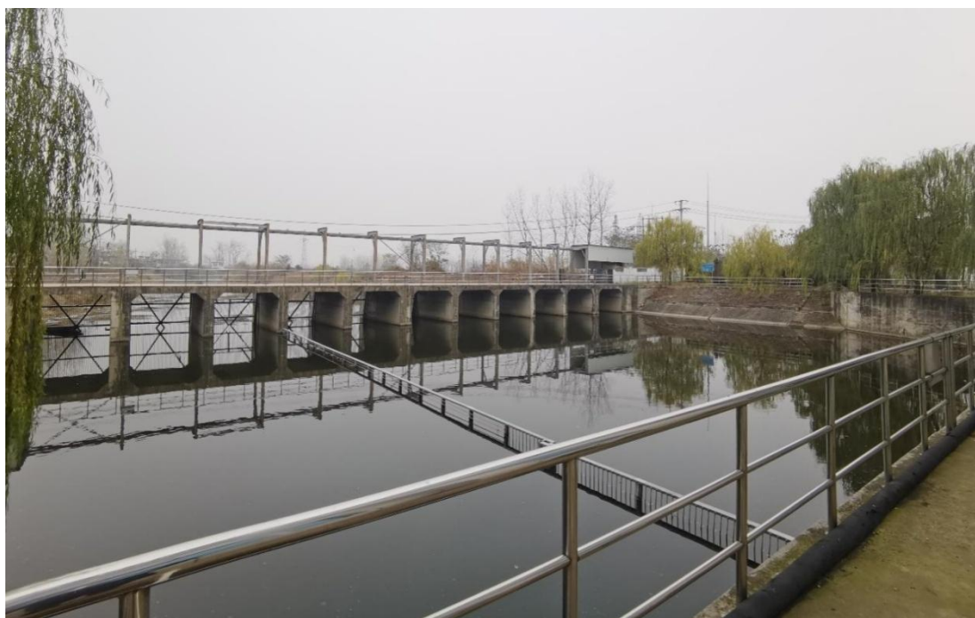
图6.8-2 三铺排涝站截断措施
