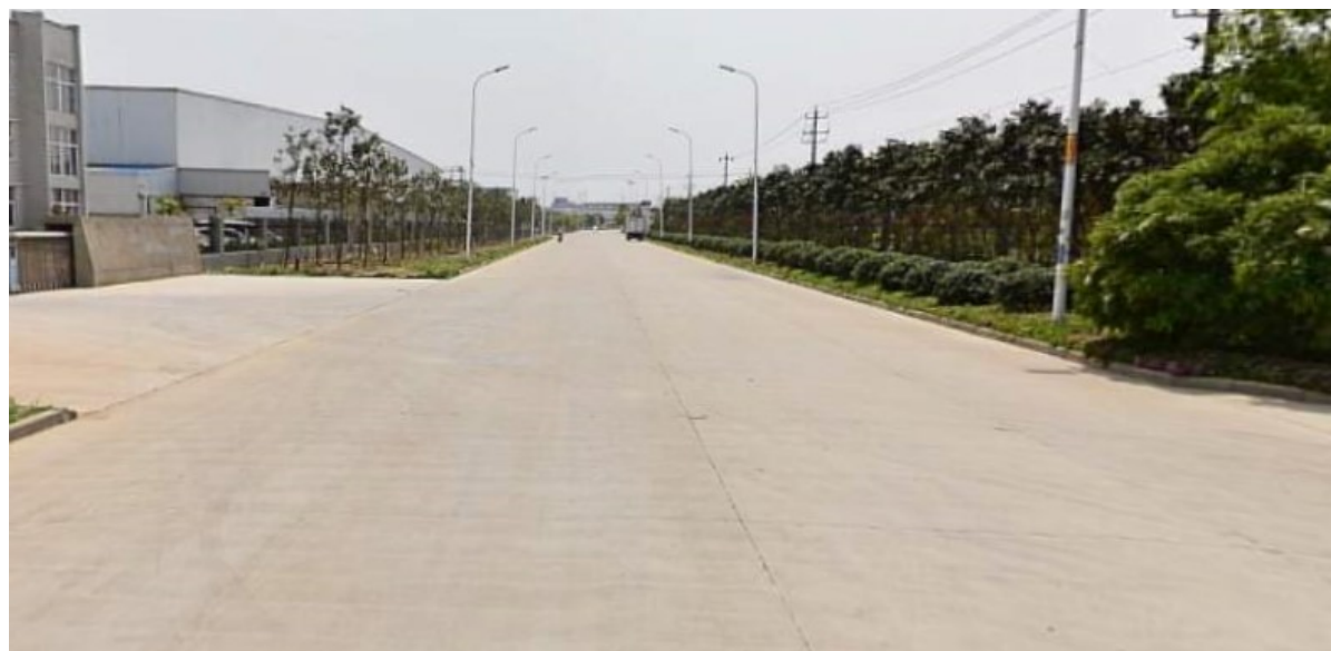
图 10 现状道路照片
