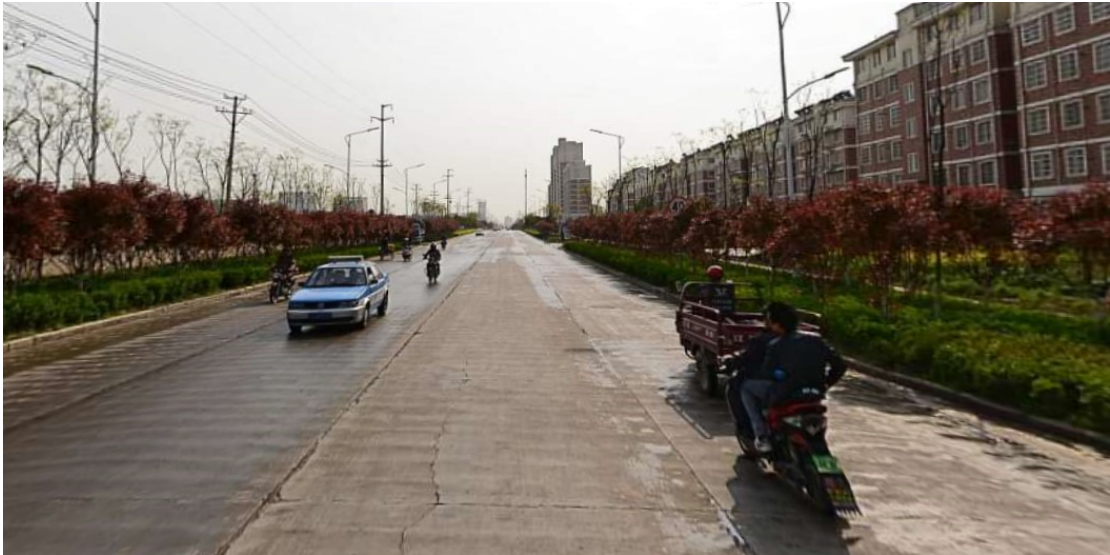
图 1 现状道路照片
