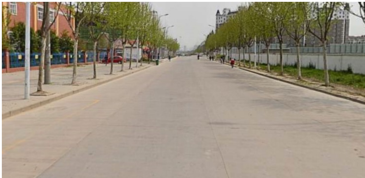
图 9 现状道路照片
