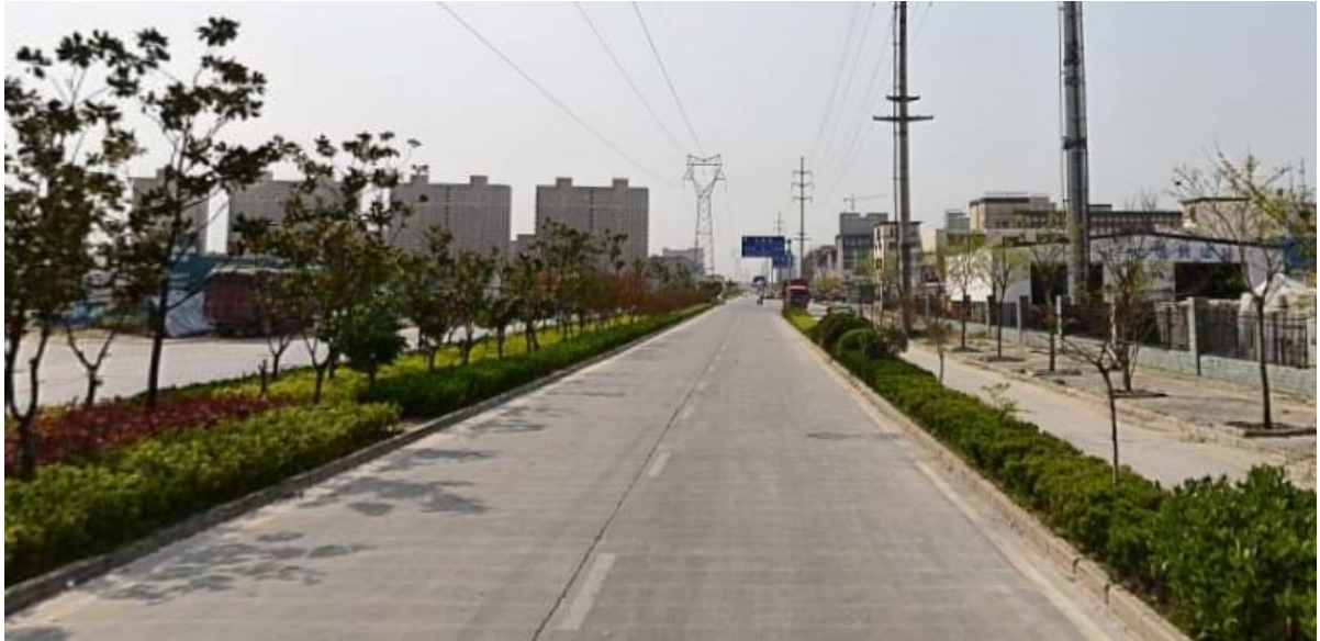
图 7 现状道路照片
