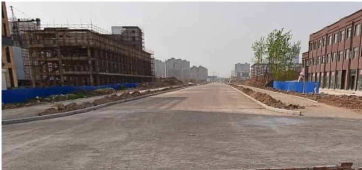
图 3 现状道路照片
