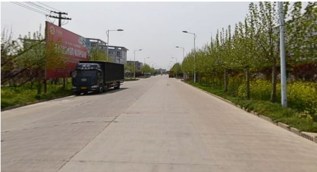
图 2 现状道路照片
