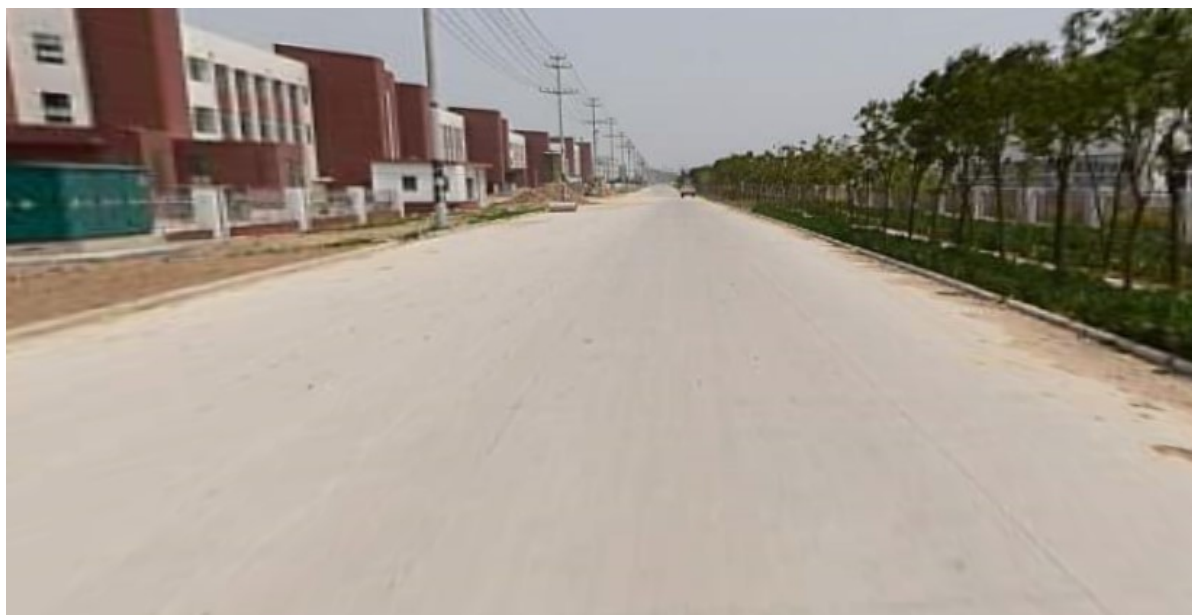
图 11 现状道路照片
