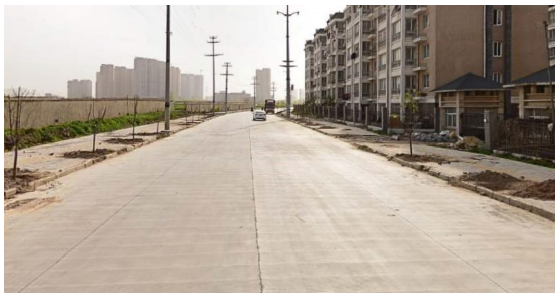
图 6 现状道路照片
