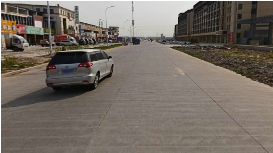
图 8 现状道路照片
