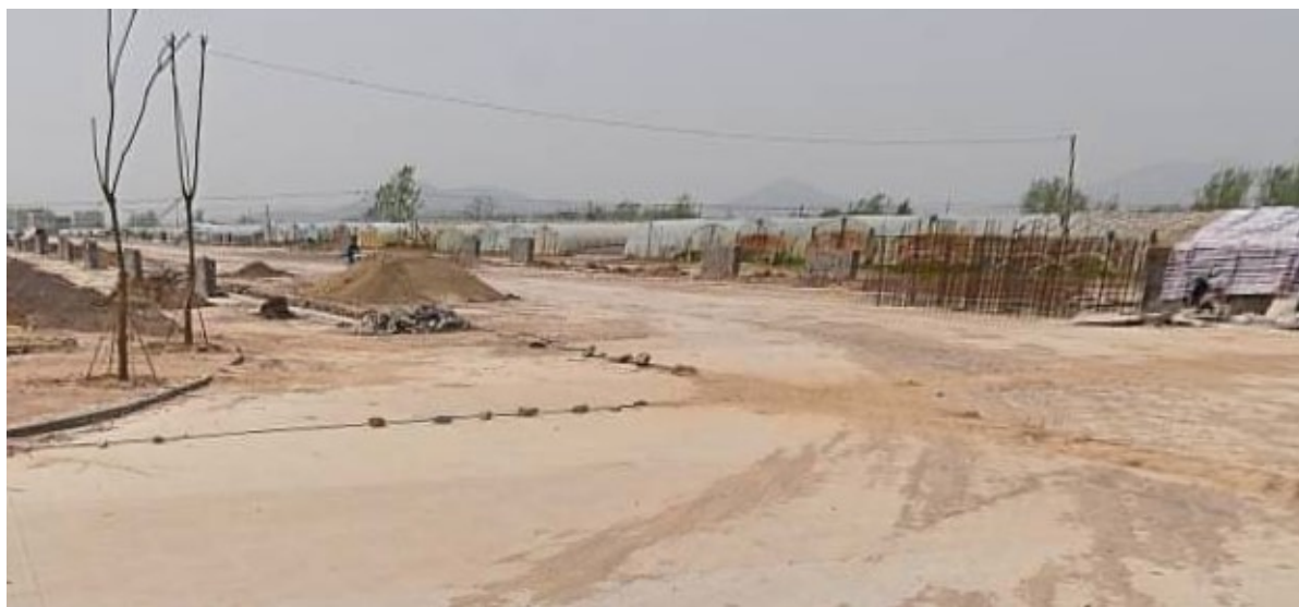
图 12 现状道路照片
