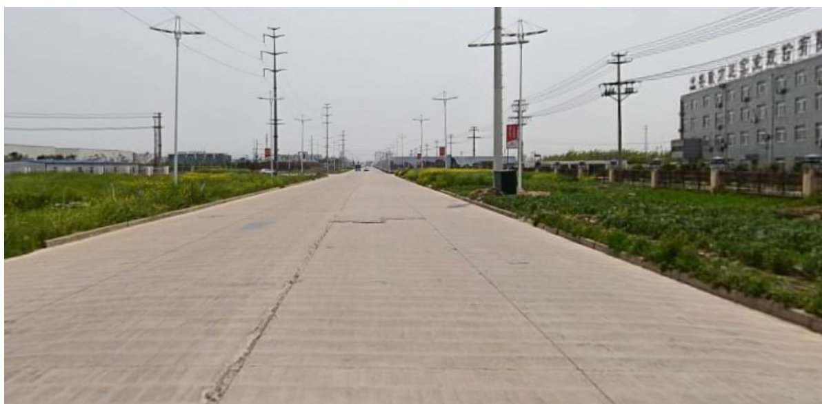
图 13 现状道路照片
