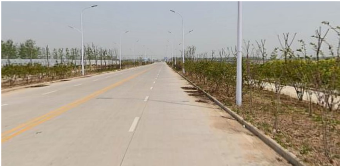
图 5 现状道路照片
